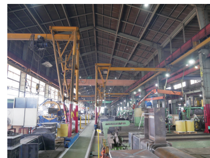
柱工場内部の様子
