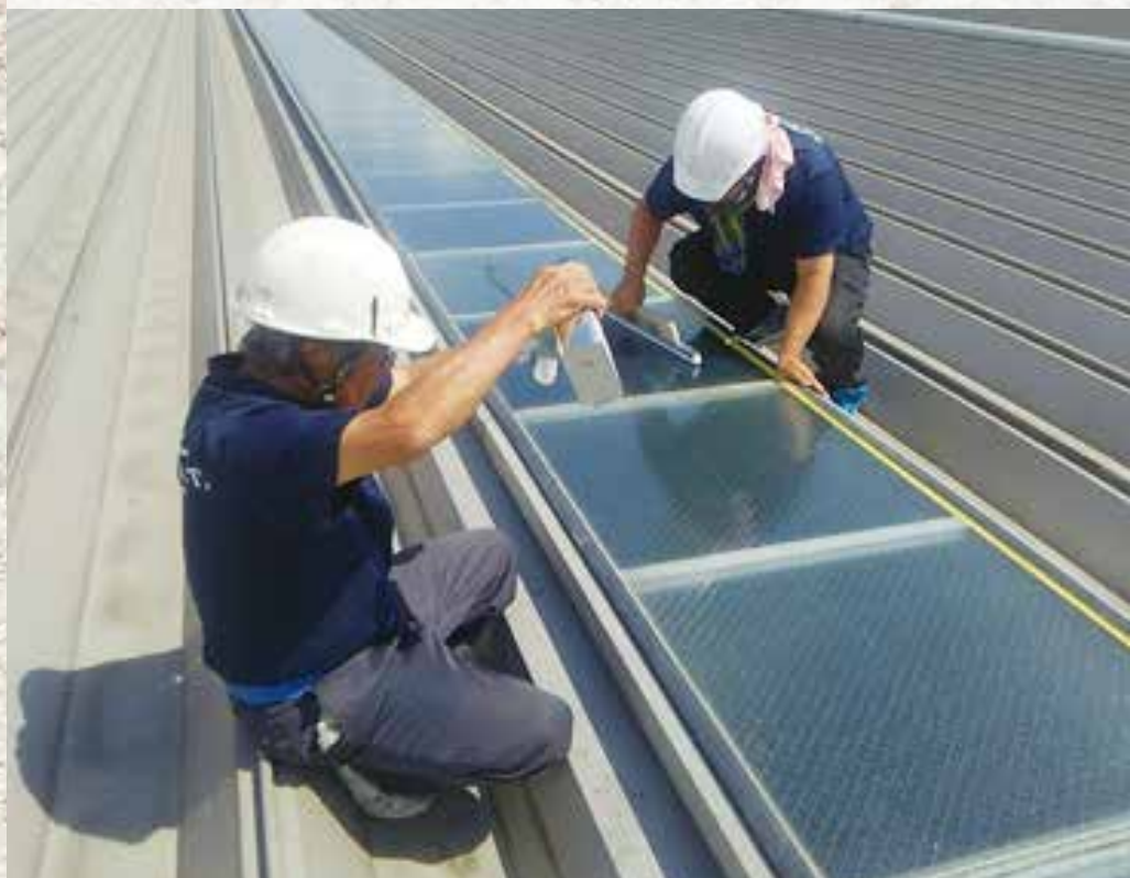
ZERO COAT 液剤の施工の様子
