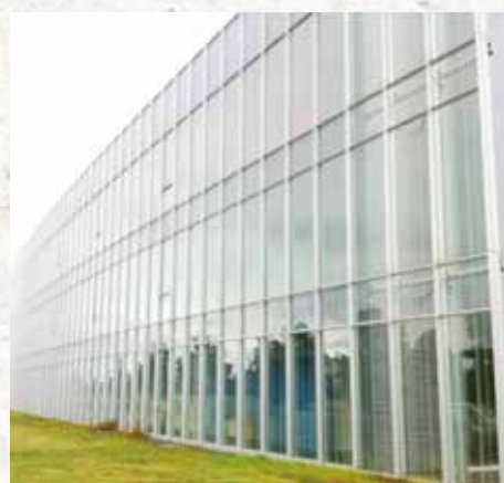
ZERO COAT の施工事例（東洋大学板倉キャンパス）
