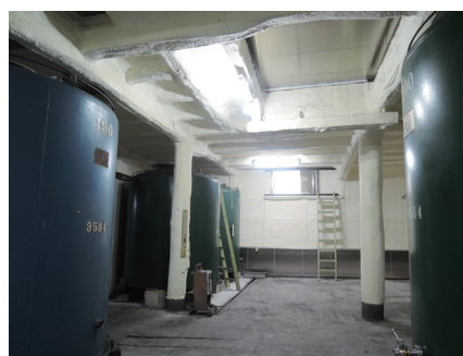
約37坪の土蔵の貯蔵庫に断熱工事を施した
