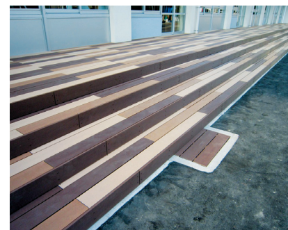
人工木ウッドデッキ（特許第5441963号・第6263759号）の施工例
