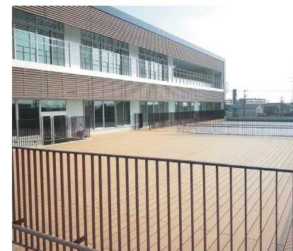
ルーバーとデッキの施工例
