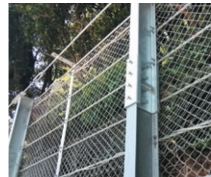
既設支柱とかさ上げ用支柱の接合部
