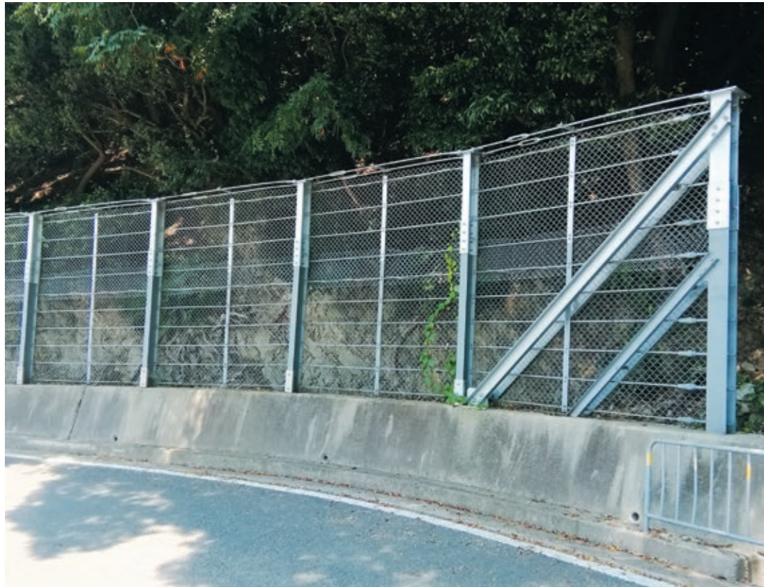
「ストロンガー工法」の施工例
