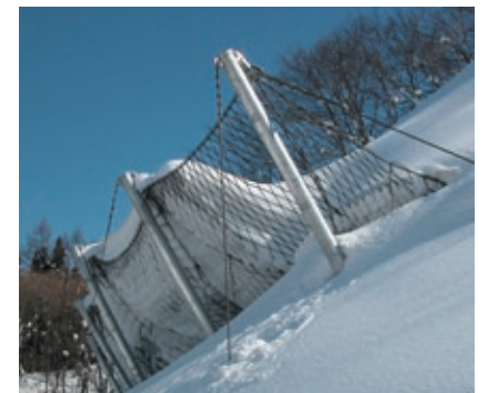
「三角フェンス」の施工例
