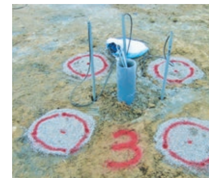
築造中の碎石パイル
