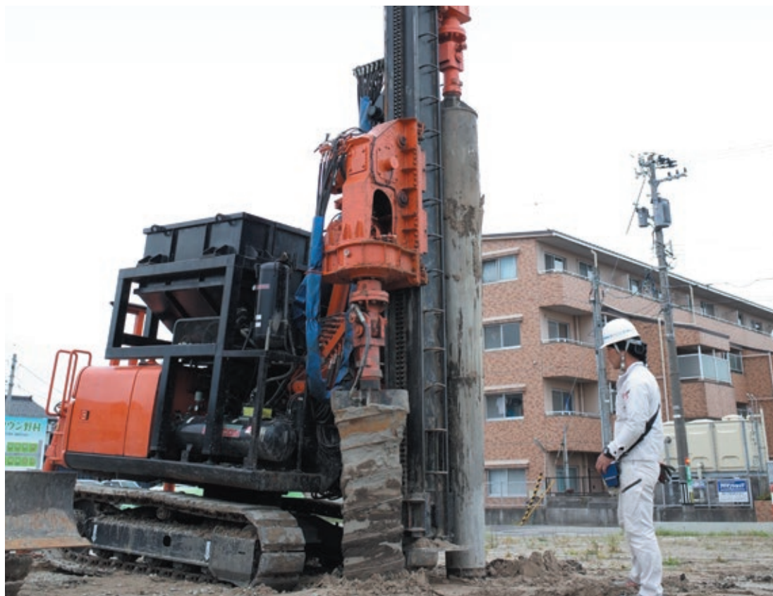
新工法による地盤改良工事の様子
