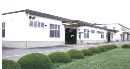
本社 第1第2工場
