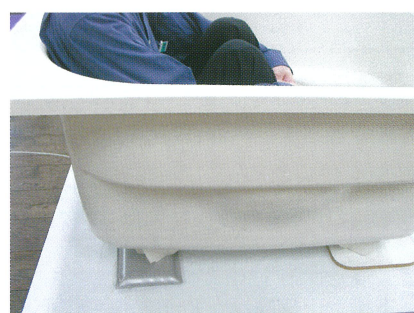
浴槽、左脚部下設置されたセンサーユニット
