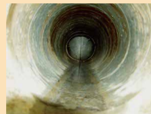
清掃後のダクト
