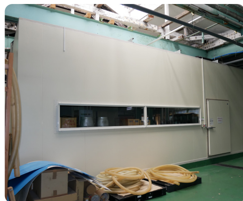
新設したクリーンルーム
