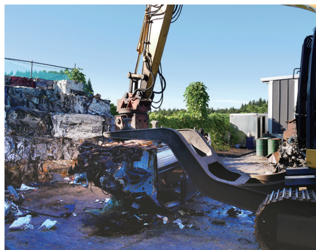
自動車解体用切断機を使用した解体作業の様子
