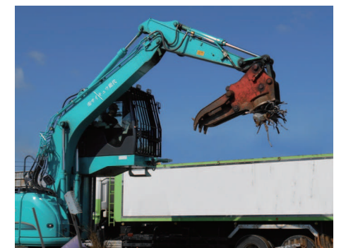
マグネットチャックによる作業風景
