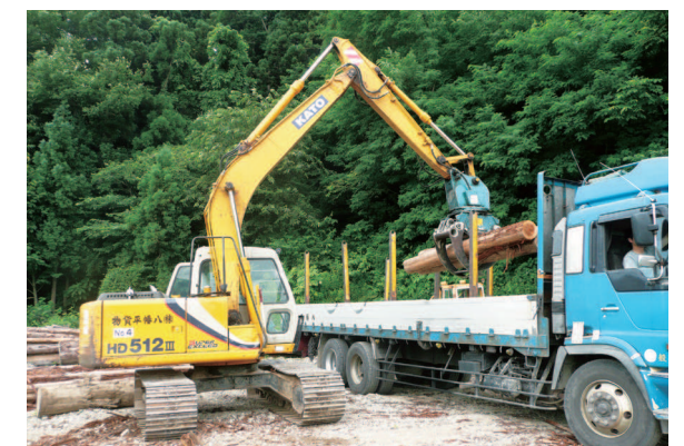
積込作業風景②
