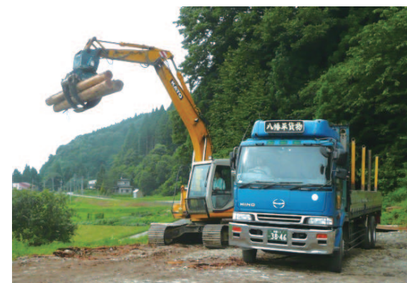
積込作業風景①
