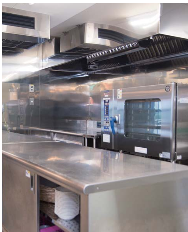
冷たい料理はカートに入れてそのまま大型冷蔵庫に、温かい料理はホットワゴンに。スチームコンベクションオープン、皿を温めておく保温機。
