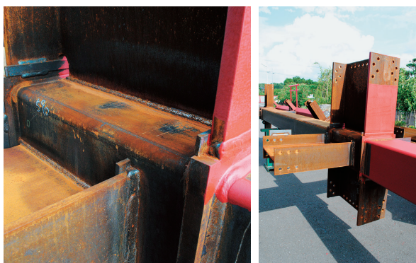
長い鉄骨にさまざまな部品を溶接して、製品に仕上げる
