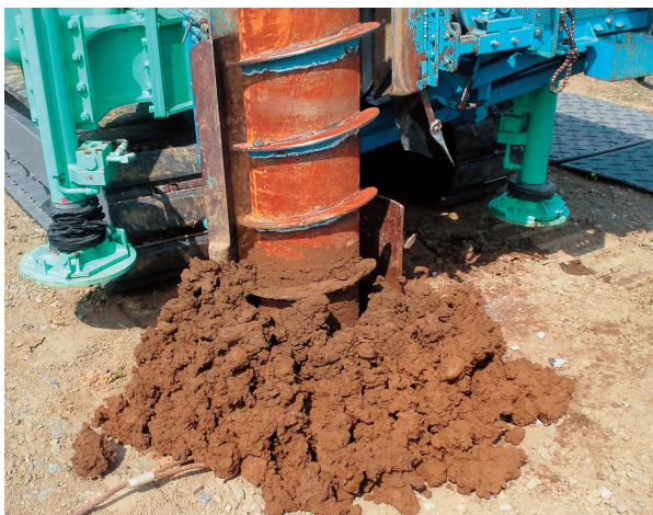
施工状況。写真左が従来の排土型ケーシング、写真右は無排土型ケーシングによる施工状況（排出土砂がない）
