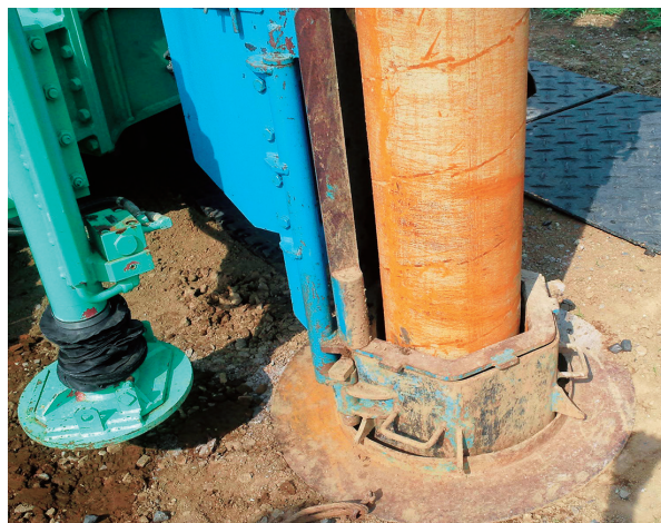
施工状況。写真左が従来の排土型ケーシング、写真右は無排土型ケーシングによる施工状況（排出土砂がない）
