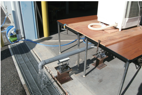
漏水試験の様子
