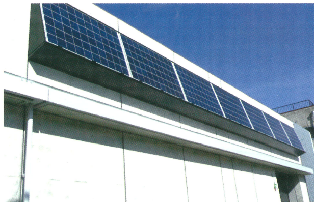
壁面への取り付け例
