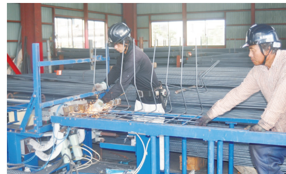
鉄筋の溶接作業
