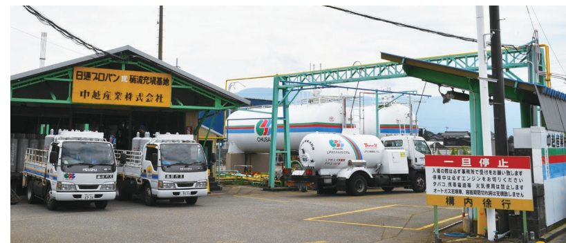
処理工場に隣接するLPガス充填工場
