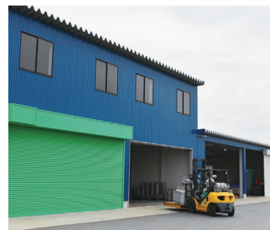
今回の事業のために建設された処理工場と保管専用ヤード
