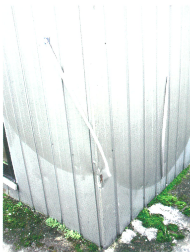
西川鉄筋の社屋壁面に取り付けられた風ホウキ。布が揺れる部分だけ汚れていない
