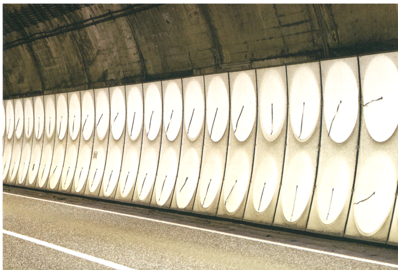
風ホウキが取り付けられた国道8号線横尾トンネル（富山県朝日町）。トラックの強い風圧を受けると、布は真上まで揺れることがある
