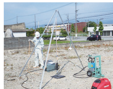
動的回転式サウンディング試験（DSPT）。N値（地盤の硬さを示す指標）20まで測定可能で、傾斜地や超狭小地で能力を発揮する
