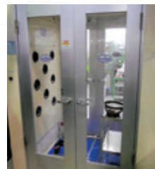
クリーンルーム
