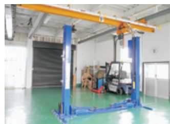
大型クレーンと2柱リフトを完備した計測スペース
