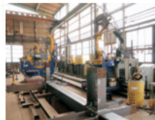
溶接ロボット
