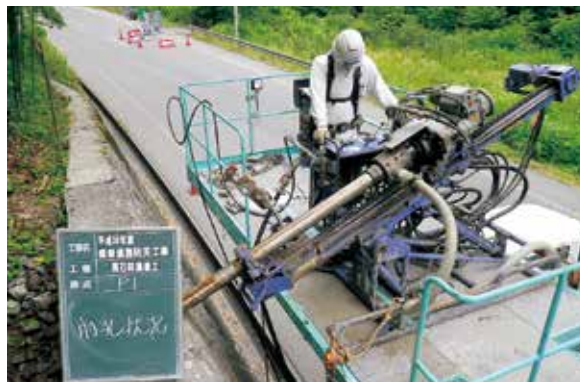
高所作業車を利用した削孔状況
