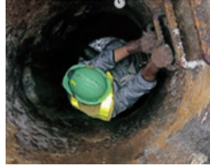
マンホール内目視作業
