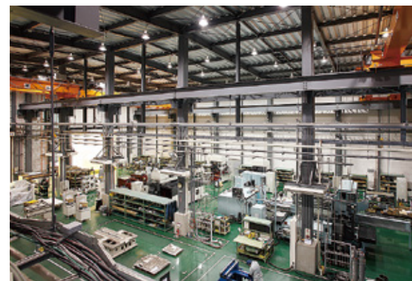
2008年に完成した組立工場
