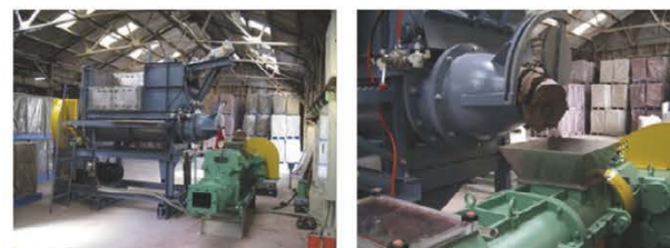
混練機と真空式土練機の設置と試運転
