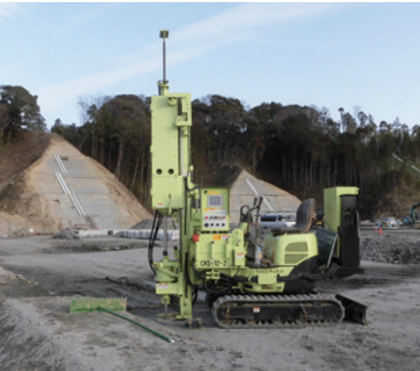
新造試験機による盛土管理
