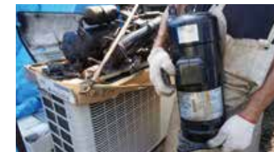
空調機の据付も得意
