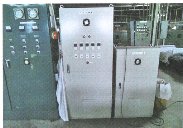
POINT2：テンション制御装置
