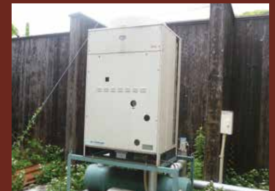
【菌の増殖を抑える冷却装置】
