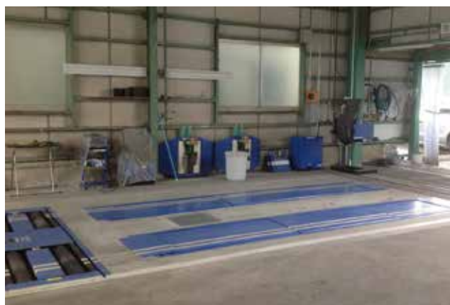
増設したリフト
