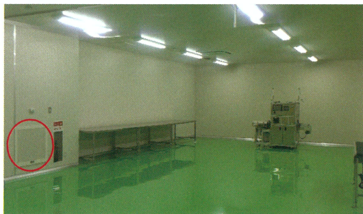
▲隔離部屋 赤丸は外部への排出用フィルター（HEPA）
