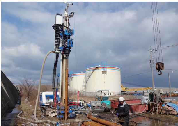
ダブルロータリー工法ボーリングマシンSM-10GT
