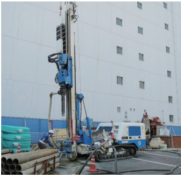
都市部でのボーリング工事の様子
