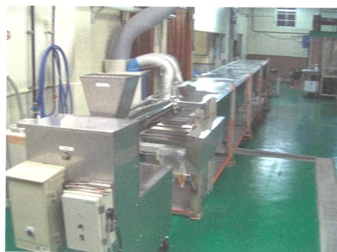
蒟蒻加工食品等の製造工場内部
