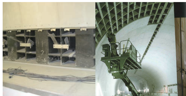
【図2】トンネル耐火板取付け
