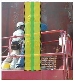
【従来の加熱処理部分400mm】
