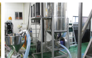
サニタリー設備
