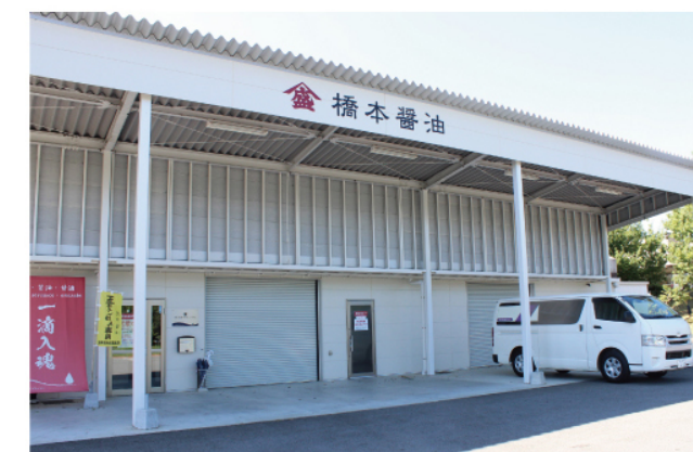
▲フードパル熊本内にある本社・工場
