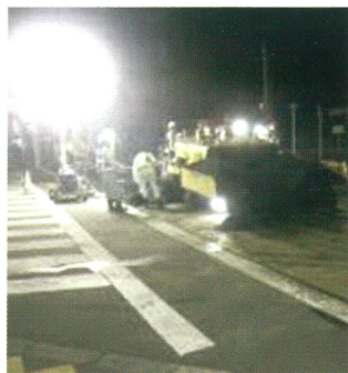
【図1】夜間工事現場
