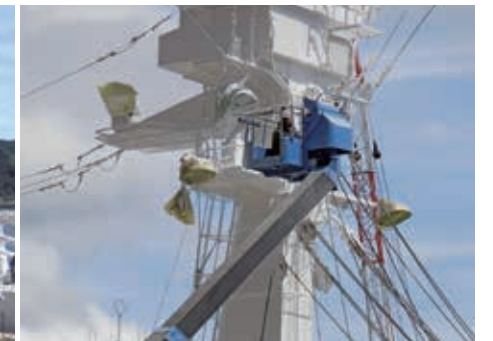
高所作業の様子
