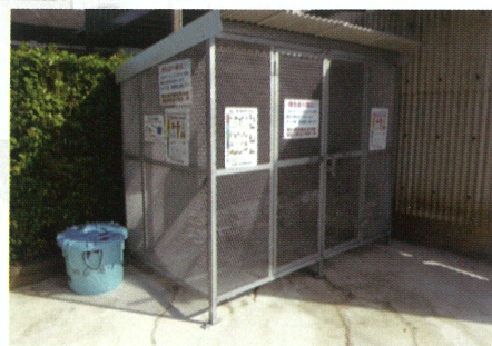
一般廃棄物の収集場所に設置された容器
