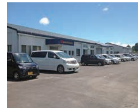
鹿児島工場全景
