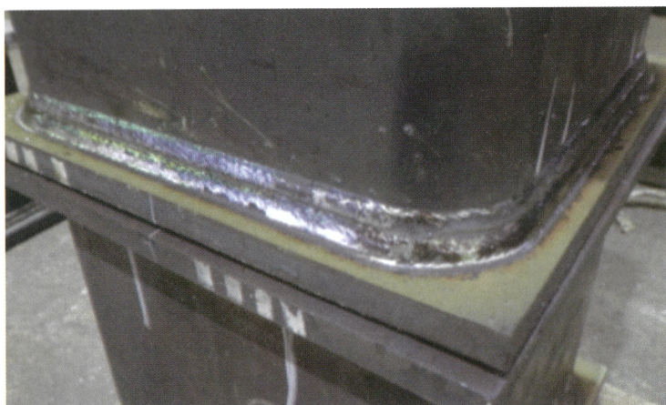
溶接したコーナー部
