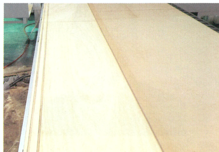
パネル加工後（溝切削加工）
