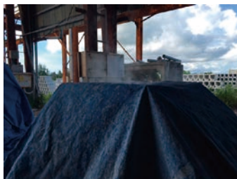
蒸気養生の様子
