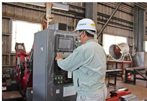
全自動ユニットワーカー制御盤（データ入力し、自動的に切断・穴あけ）
