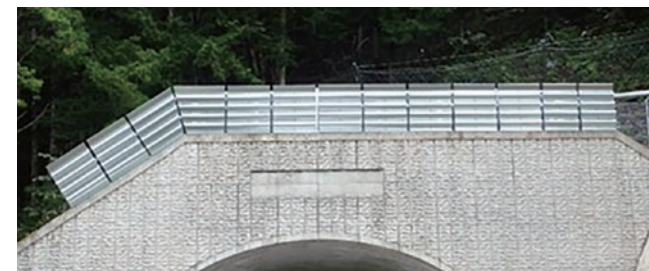
▲ DC パネル開発のきっかけとなった雪庇防止柵「SCP フェンス」
